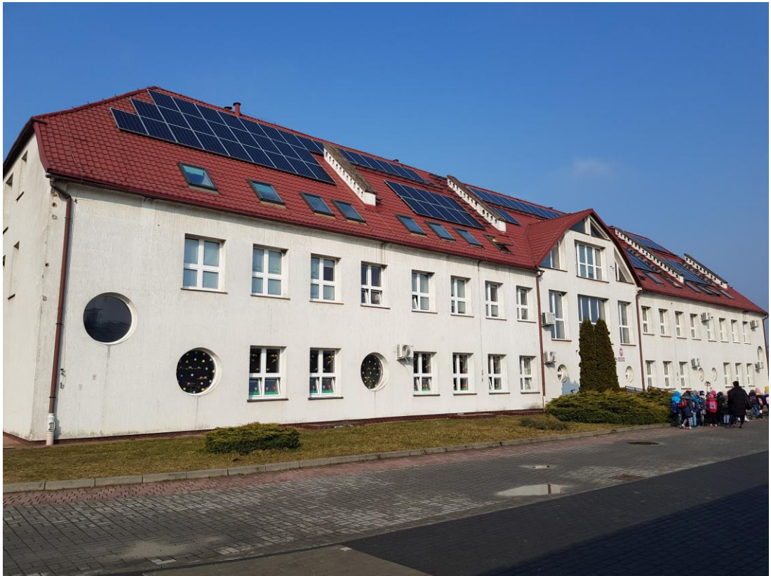
Rys. 21. Budynek Przedszkola w Skarbimierzu - Osiedlu
