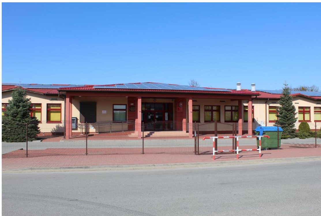
Rys. 20. Budynek szkoły w Skarbimierzu – Osiedlu
