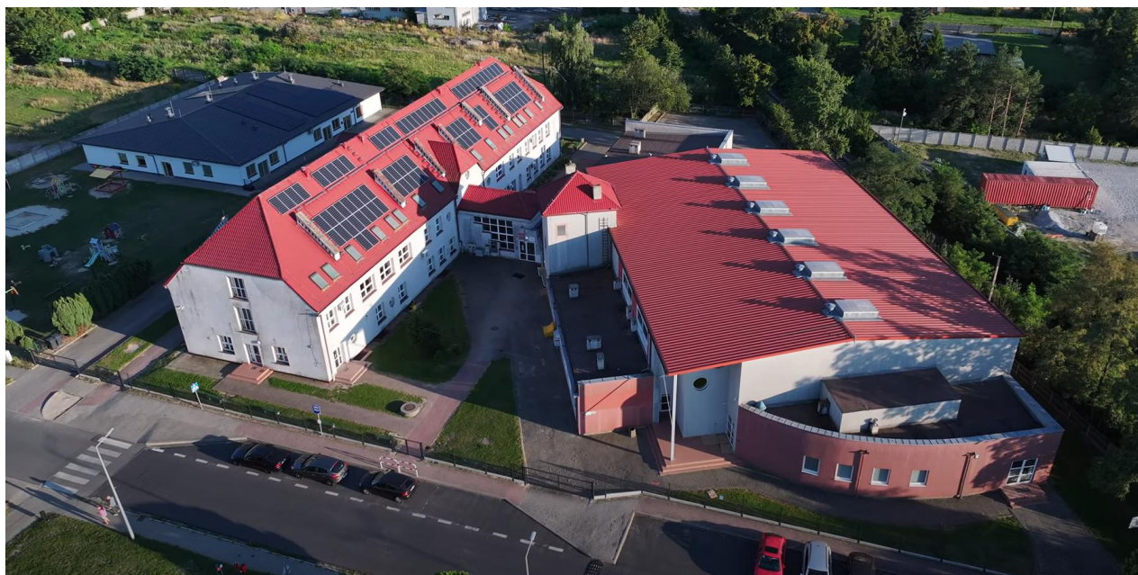
Rys. 19. Budynek szkoły oraz budynek przedszkola w Skarbimierzu – Osiedlu
