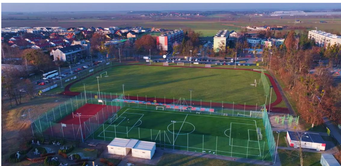
Rys. 24. Boiska sportowe w Skarbimierzu – Osiedlu
