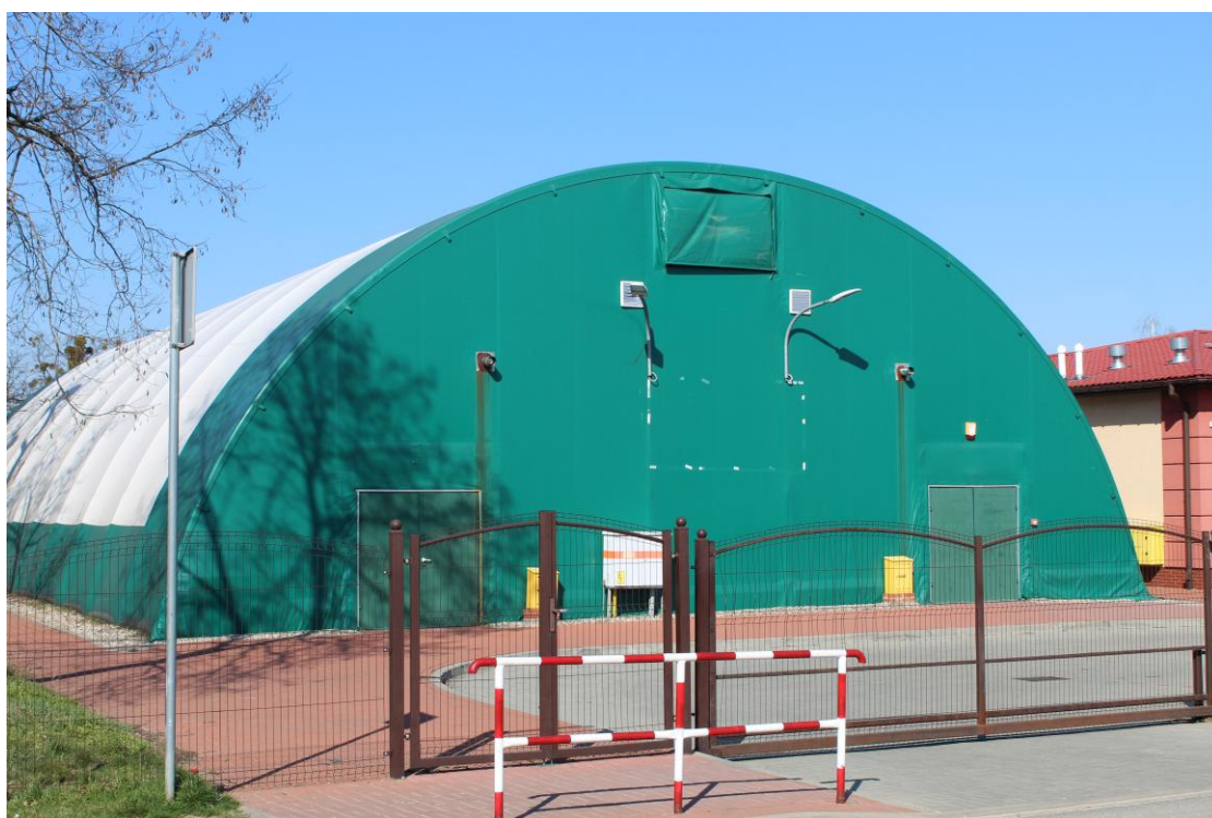
Rys. 25. Hala sportowa w miejscowości Skarbimierz-Osiedle
